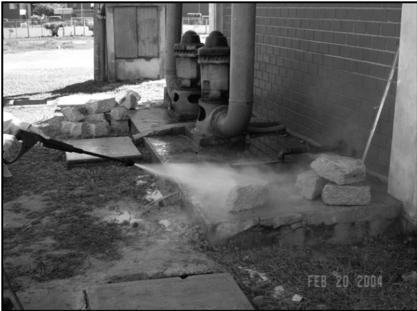
Figura 2. Lavado a presión de las probetas de hormigón para eliminar contaminantes.
