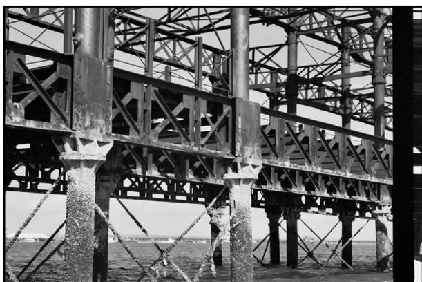
Figura 7. Corrosión en jácenas nivel cero, en el muelle de Riotinto.
