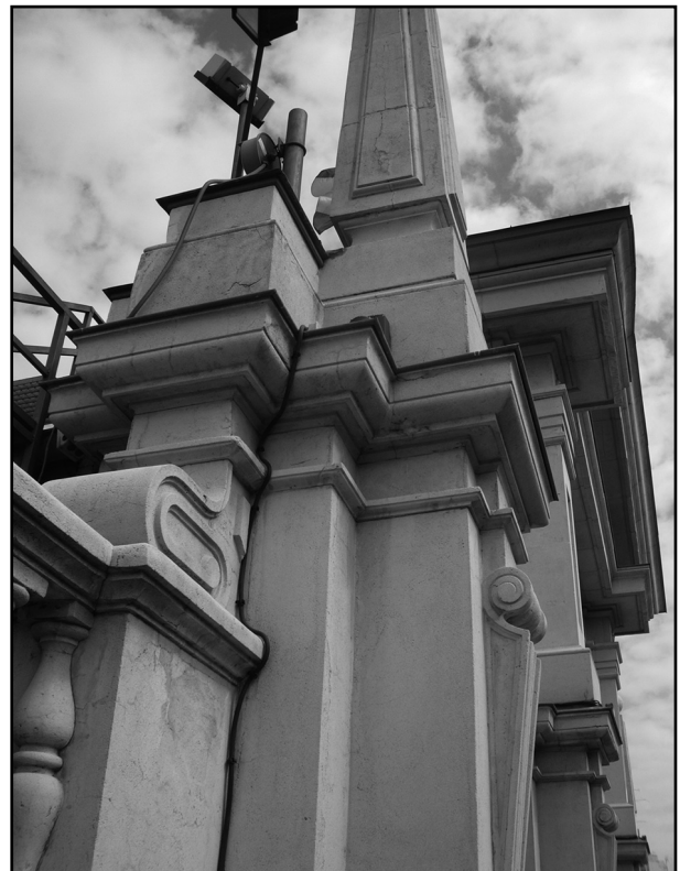
Figura 8. Detalle de cornisas y molduras.
