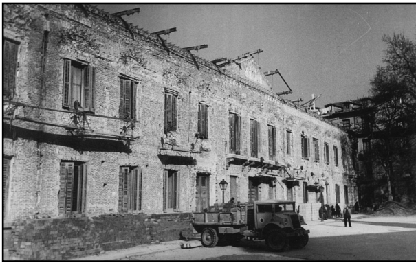
Figura 1. Fachada principal durante las obras de remoción de los revestimientos, frontis en pie de la fachada de A. Ortiz Villajos de fines del siglo XIX (fotografía 1951, Archivo del Senado de España).
