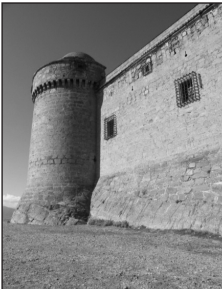
Figura 4. La base de castillo incorpora en muchos de sus muros parte de los afloramientos rocosos-carbonáticos, que fueron utilizados como cantera para su construcción. Figure 4. The base of castle incorporates in many of its walls part the carbonate rock outcrops that were used as quarry for its construction.
