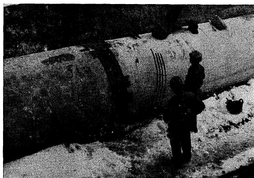
Instalación de una de las costosas tuberías de hormigón armado.
