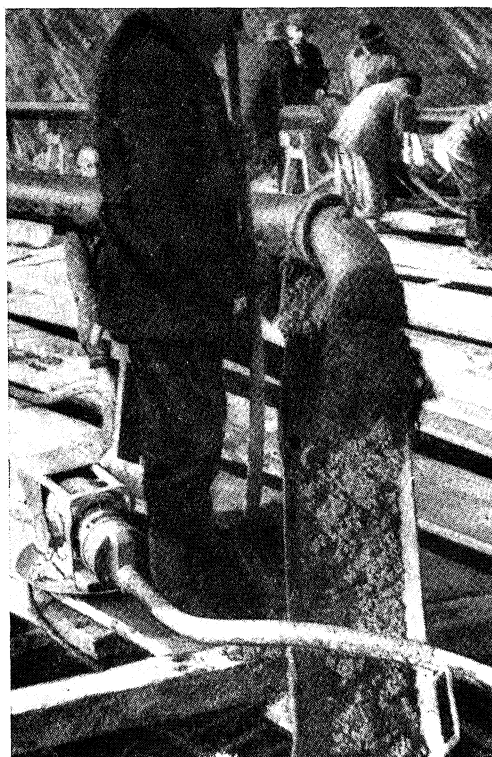
Fig. 15.—Salida del hormigón al final del tubo.
