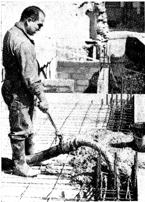
Fig. 21.—Transporte de un hormigón fluido por una tubería de diámetro pequeño.
