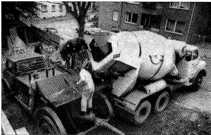
Fig. 16.—Transporte posterior del hormigón preparado con un vehículo autobomba.
