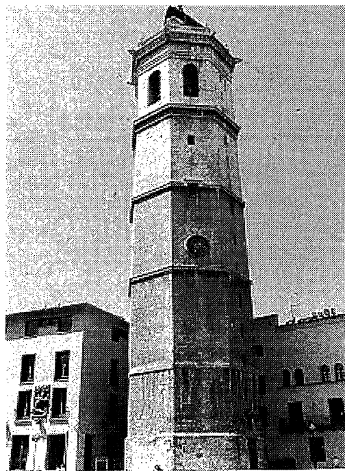
Figura 2.- Torre-Campanario "El Fadri" de la ciudad de Castellón. Figure 2.- Bell-Tower "El Fadri" at Castellon city center.
