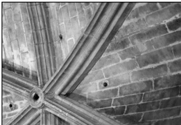
Figura 1. Bóveda de la catedral de Sevilla. Plamentos y nervaduras. Diferentes espesores de juntas de mortero en sus fábricas. Figure 1. Vault in Seville Cathedral. Severy and rib masonry with different mortar joint thicknesses.
