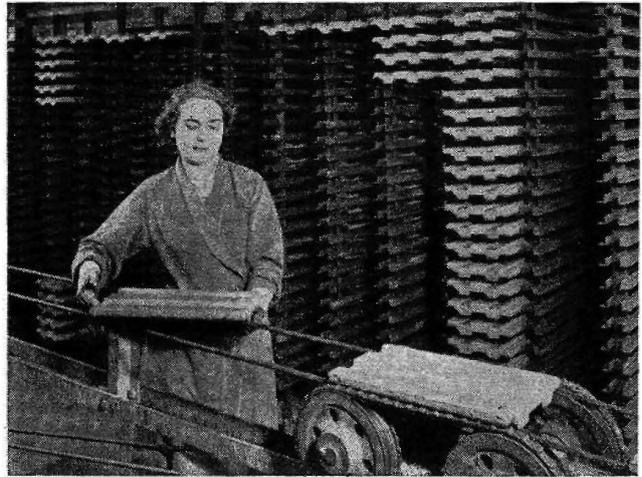
Fig. 4.—Colocación en los anaqueles de las tejas recién fabricadas.
