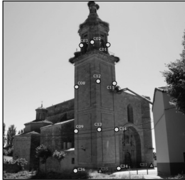
Figura 1. Localización de las señales de la torre. Las señales C31 y C35 definen el sistema de referencia. Figure 1. Placement of the targets on the tower. Points C31 and C35 define the reference system.
