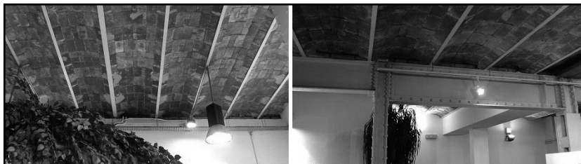
Figura 1. Vista inferior típica de los forjados estudiados. Figure 1. Typical bottom view of the slabs studied.
