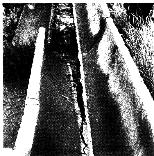
Fig. 2.—Canaleta para conducción de agua.
